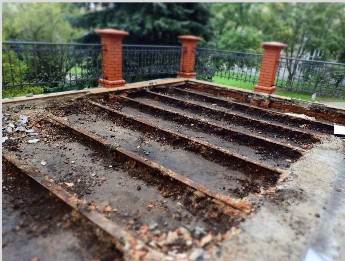
Widok istniejącej płyty stropowej
