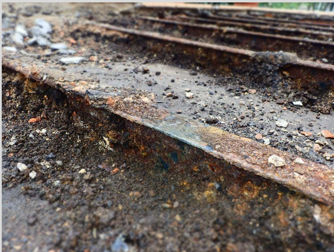
Korozja belek powierzchniowa – brak obserwowanych większych ubytków przekrojów.
